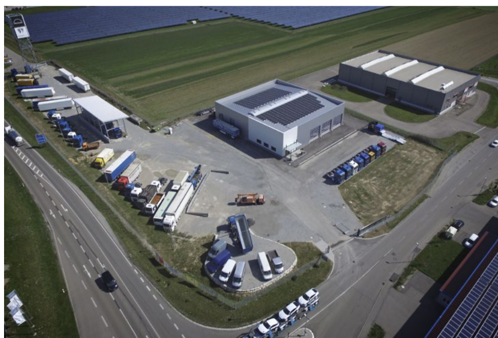
Das große Gebäude in der Mitte des Fotos ist die neue Ausstellungshalle von BFS und Stegmaier Nutzfahrzeuge. In Kürze wird auf dem Gelände eine Portalwaschanlage entstehen.
